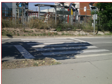
Fig. 6.1.3.4. Voreira no accessible (Av. del Riu Ripoll)
